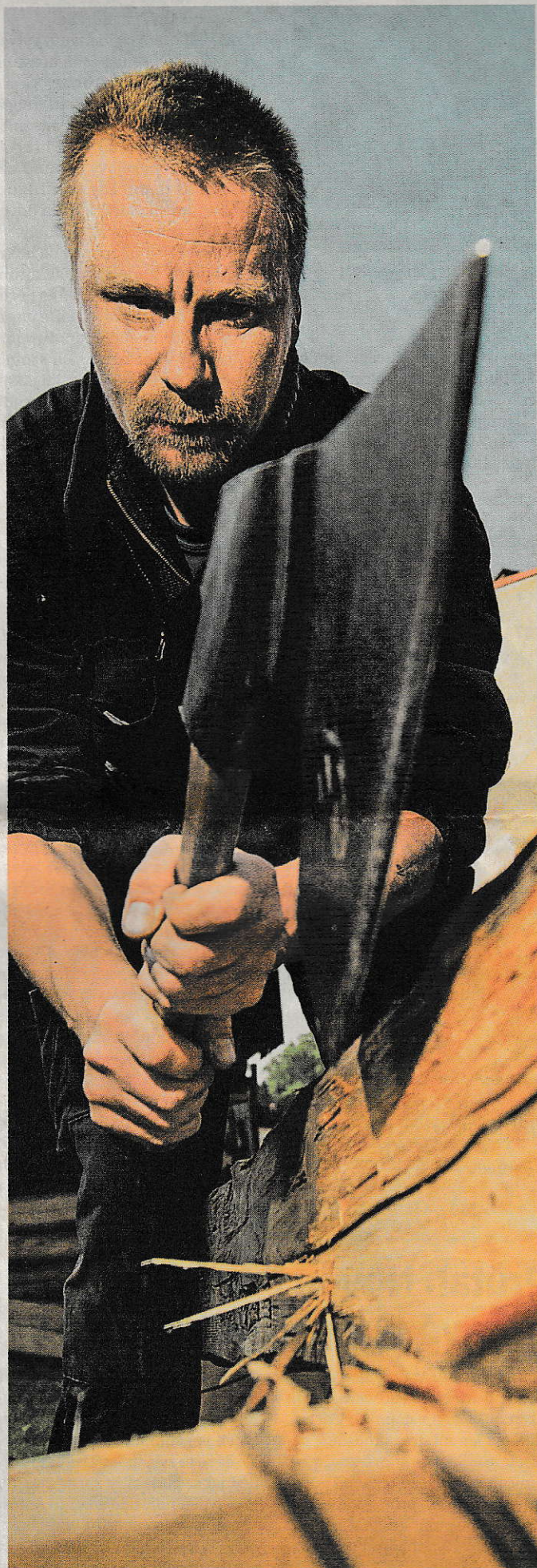
Ruční práce Tesař Martin Zeman přitesává trámy unikátní roubenky Dřevěnka v Úpici na Trutnovsku. Národní kulturní památka prochází náročnou rekonstrukcí. » Více čtěte na str. B2
