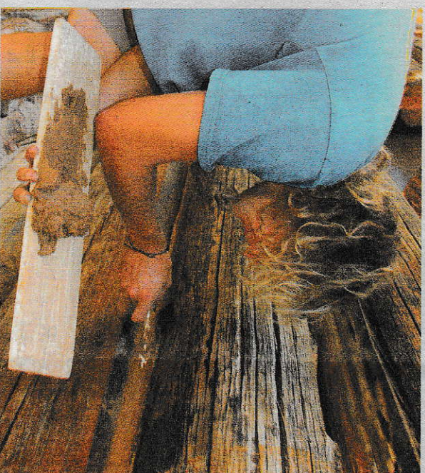
VYMAZÁVÁNÍ. Spáry tesaři během nadcházejících dvou měsíců zaplní díky znalosti historické techniky. Foto: Deník/Jar. Pich
