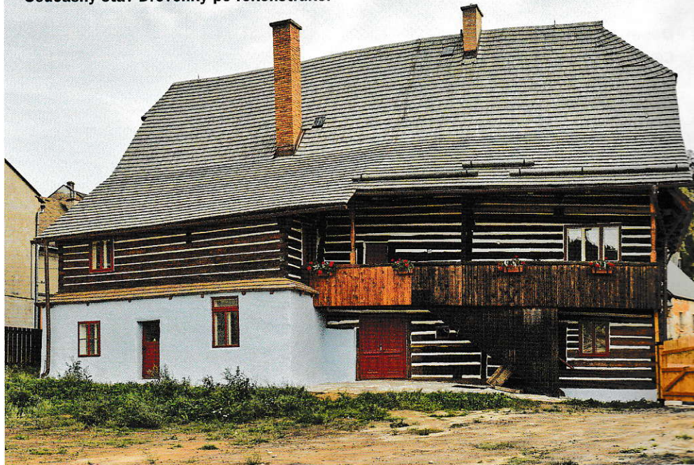
Současný stav Dřevěnky po rekonstrukci
