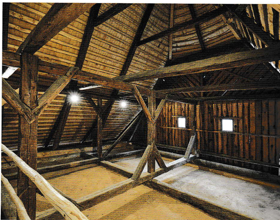
Mistrovské dílo tesařů i restaurátorů – krovová konstrukce, vyšší než dvě obytná patra Dřevěnky
