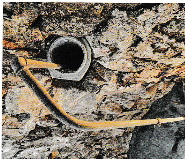
Původní pivovod zachovaný ve sklepe
