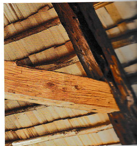
Detail krovové konstrukce s novou krytinou – ručně štípaným šindelem
