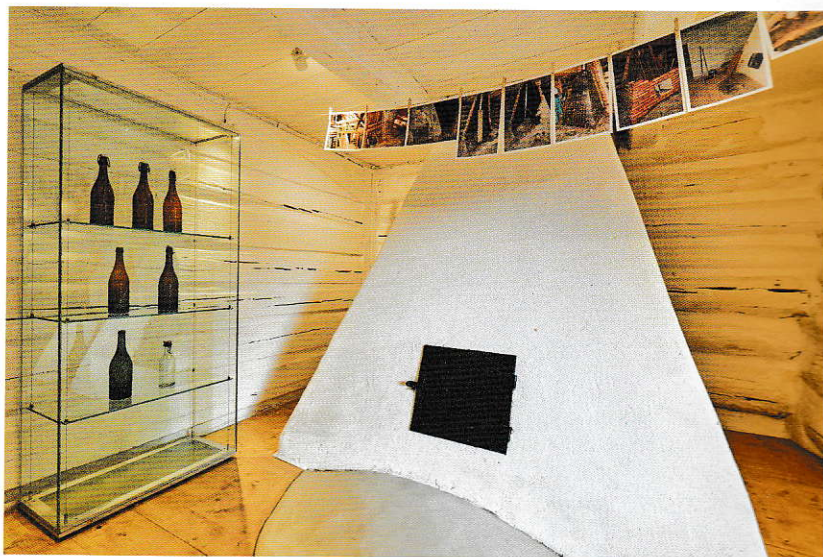
Roubené stěny bílené vápnem
